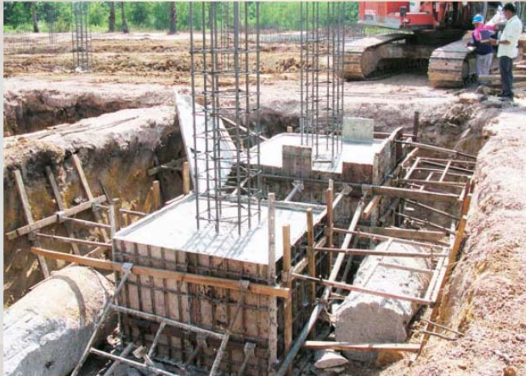
ฐานรากเสาเข็มพร้อมเหล็กเสาตอม่อ
