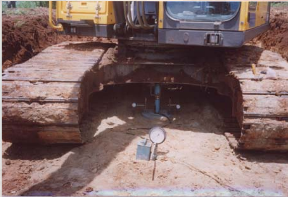
การติดตั้งอุปกรณ์ทดสอบแผ่นเหล็ก
