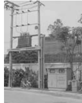
๑๔.๒ รอบเสาหม้อแปลง(นั่งร้าน)มีพื้นที่ต่อการซ่อมบำรุง
