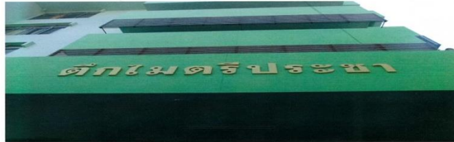
ภาพทั่วไปภายนอกอาคารมั่นคงแข็งแรง
