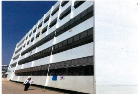
สภาพทั่วไปภายนอกอาคารมั่นคงแข็งแรง
