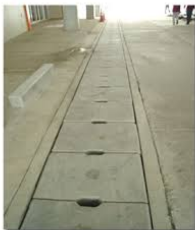
รูปที่ 4.4 ภาพแสดงฝาปิดและแนวระบายน้ำ
