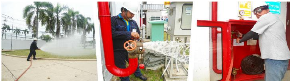
รูปที่ ๗.๑๖ แสดง การทดสอบการปล่อยน้ำดับเพลิง
