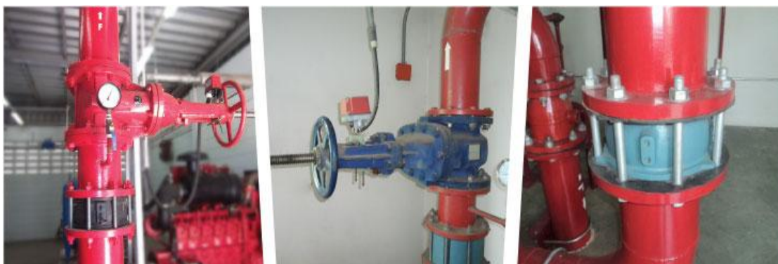
รูปที่ ๗.๗ แสดงวาล์วต่างๆ Supervisory Switch
