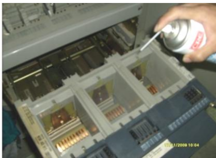
รูปที่ ๒.๑๖ แสดงการใช้น้ำยาทำความสะอาดหน้าสัมผัส
