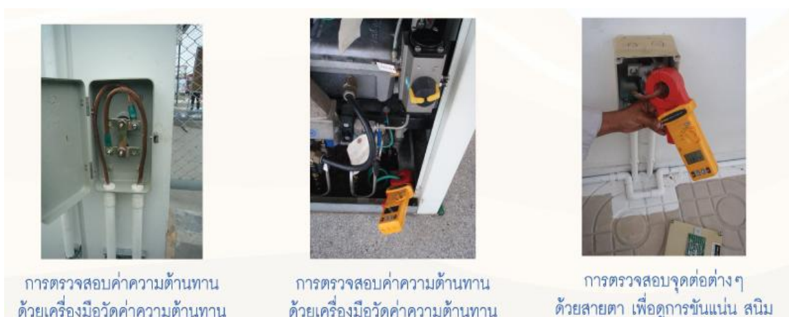
รูปที่ ๔.๕ แสดงการใช้เครื่องมือวัดค่าความต้านทางเดินที่สายกราวด์
