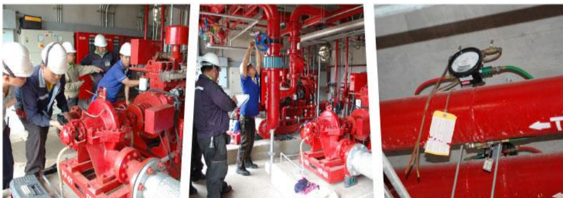
รูปที่ ๗.๑๔ แสดง การตรวจวัดความเร็วรอบขณะทำการทดสอบ Performance Test Fire Pump
