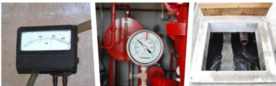
รูปที่ ๗.๑๕ แสดงทดสอบที่อัตราการไหล ๐% Rated Flowmeter ทดสอบที่อัตราการ ไหล ๑๕๐% Rated อ่านค่าแรงดันที่ Pressure Gauge ด้านจ่าย
