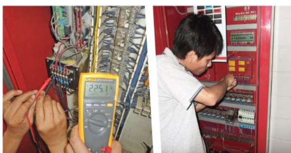
รูปที่ ๗.๖ ตรวจสอบสภาพและทดสอบการทำงานของระบบ ควบคุมไฟฟ้า
