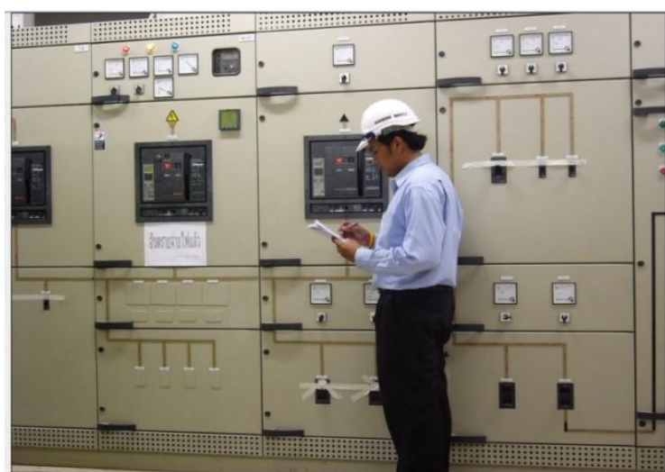
รูปที่ ๒.๑๓ แสดงการตรวจตู้ควบคุมไฟฟ้าหลัก
