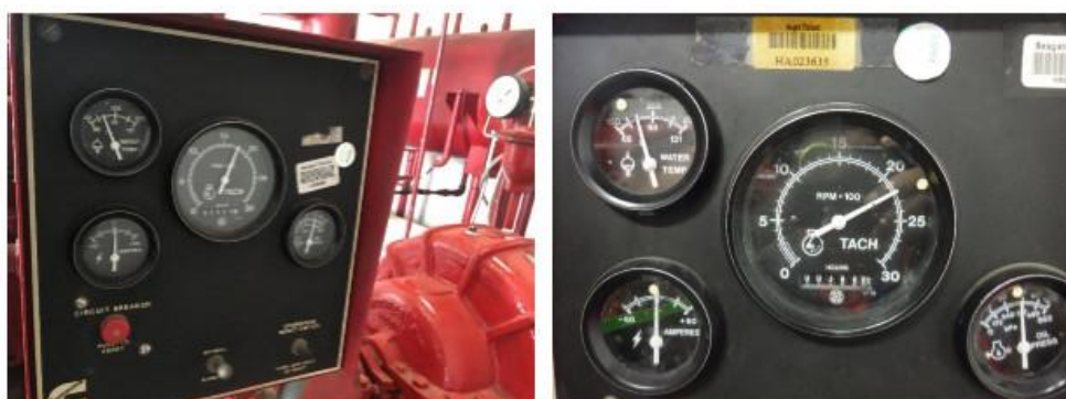
รูปที่ ๗.๑๒ แสดงมาตรวัดต่างๆหน้าเครื่อง ตรวจสอบแผงควบคุมบริเวณเครื่องยนต์
