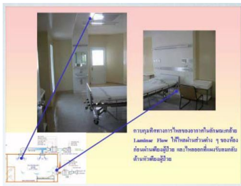
รูปที่ ๗.๑ แสดงตำแหน่งของหัวจ่ายลมและแผงรับลมกลับในห้องผู้ป่วย
