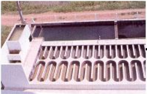
2. ถังสร้างตะกอน / ถังรวมตะกอน ถังตกตะกอน / ถังกรอง
