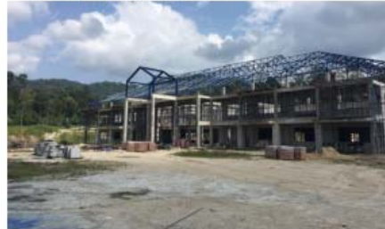
10. งานโครงหลังคา
