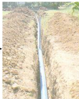
6. ท่อจ่ายน้ำ
