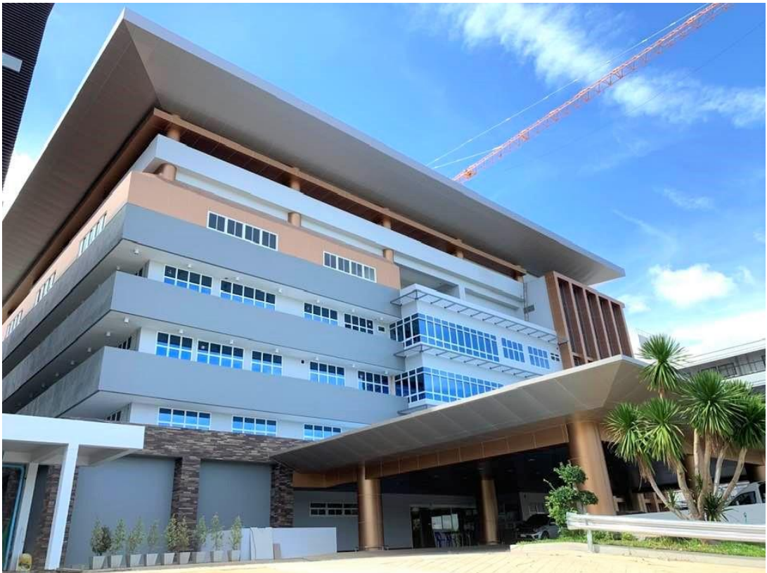
ภาพภายนอกอาคาร
