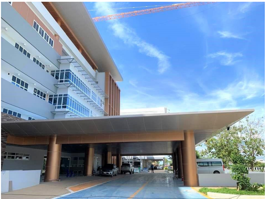
ภาพภายนอกอาคาร
