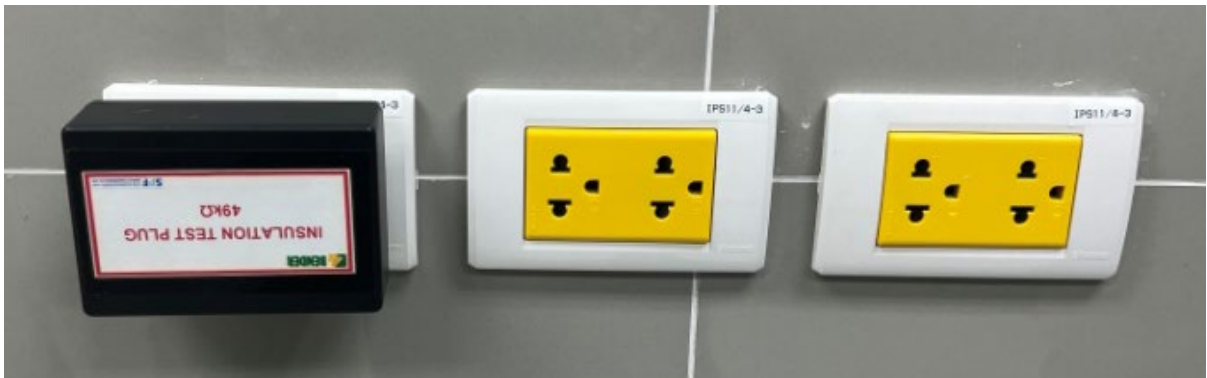
เต้ารับสีเหลืองใช้ในระบบ IT จ่ายไฟผ่านหม้อแปลงแบบแยก (Isolated Transformer)
