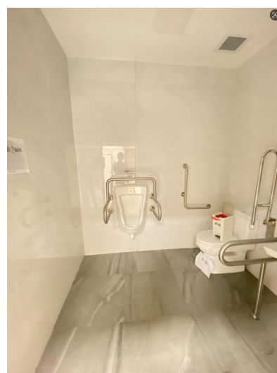
ภาพแสดงตัวอย่างการติดตั้งอุปกรณ์พุงตัวในห้องน้ำผู้พิการ
