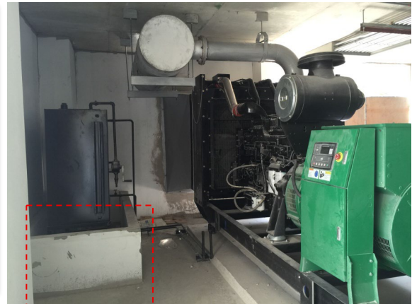
ภาพตัวอย่างแสดงเขื่อนกำแพงล้อมรอบถังน้ำมัน
