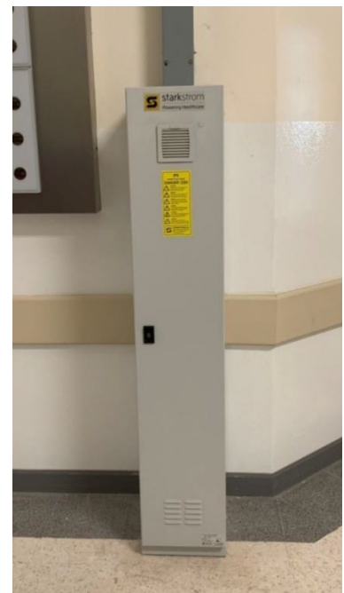
แผงควบคุมระบบ IT แบบตั้งพื้น
