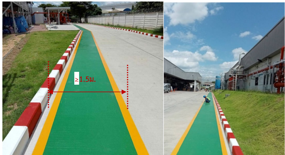
ภาพตัวอย่างแสดงการทำสี ขีดเส้น เพื่อแบ่งช่องทางสัญจร ความกว้างไม่น้อยกว่า 1.50 เมตร
